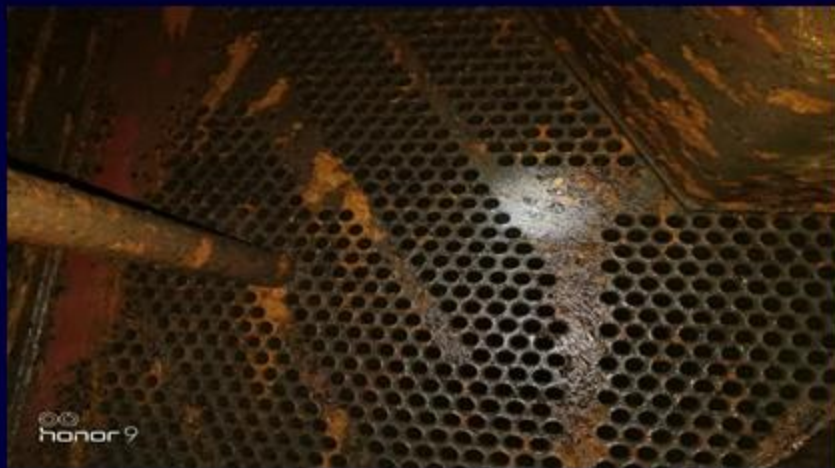
运行一年后打开凝汽器照片
